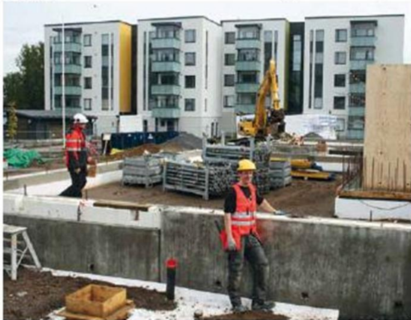
Perustusten tekoa kerrostalotyömaalla.
